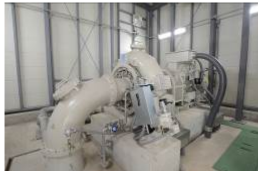
発電所内（水車発電機）
